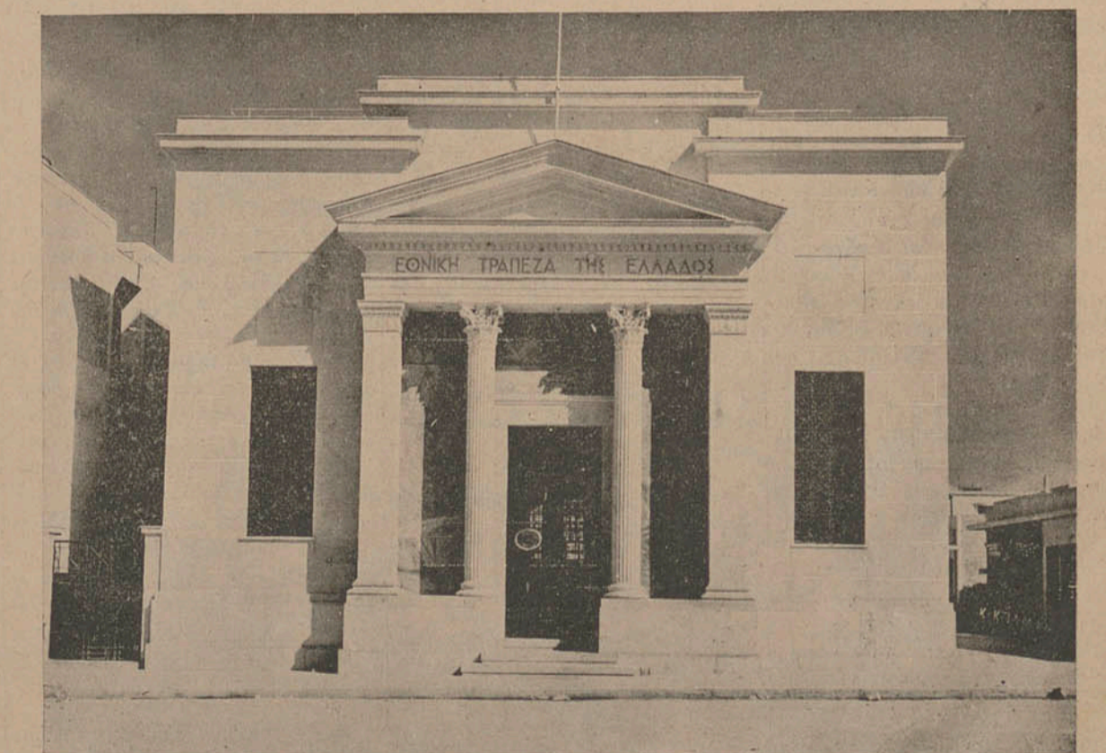
ΤΟ ΝΕΟΝ ΥΠΟΚΑΤΑΣΤΗΜΑ ΚΟΡΙΝΘΟΥ Τὸ νέον ἀντισεισμικὸν μέγαρον τοῦ ὑποκ/τος Κορίνθου ἀνηγέρθη ἐπὶ σχεδίων τοῦ ἀρχιτέκτονος κ. Ζουμπολίδου, βάσει τῶν τελευταίων πορισμάτων τῆς Ἰαπωνικῆς μηχανικῆς ἐπιστήμης διὰ τὴν ἀνέγερσιν κτιρίων εἰς σεισμοπαθεῖς περιοχάς. Τὸ νέον τοῦτο μέγαρον διακρίνεται οὖν τοῖς ἄλλοις διὰ τὸν γνήσιον Κορινθιακὸν ρυθμὸν του.
